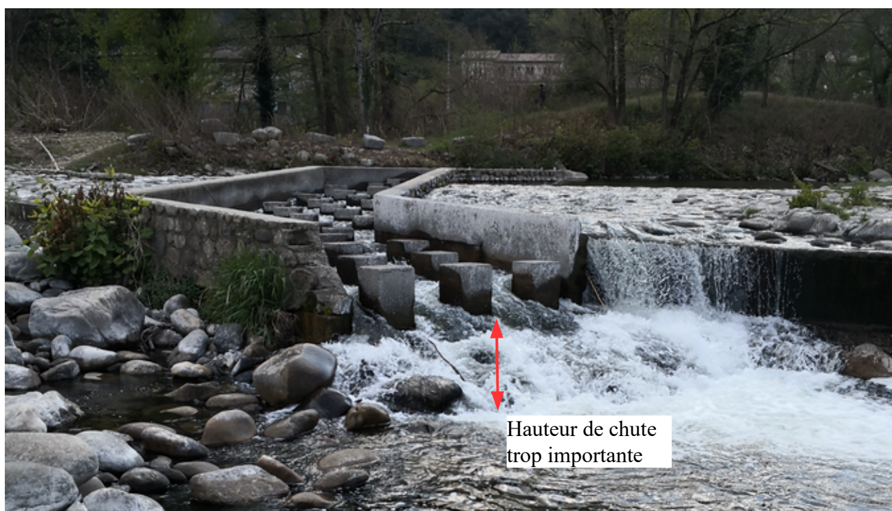
Figure 30: Exemple de mauvaise fonctionnalité d'une passe à poissons visible sur la PAP des Ollières sur Eyrieux, en aval du pont de la D120. De plus le débit d'attrait généré par la passe à canoës est sur la rive opposée à l'entrée piscicole.
